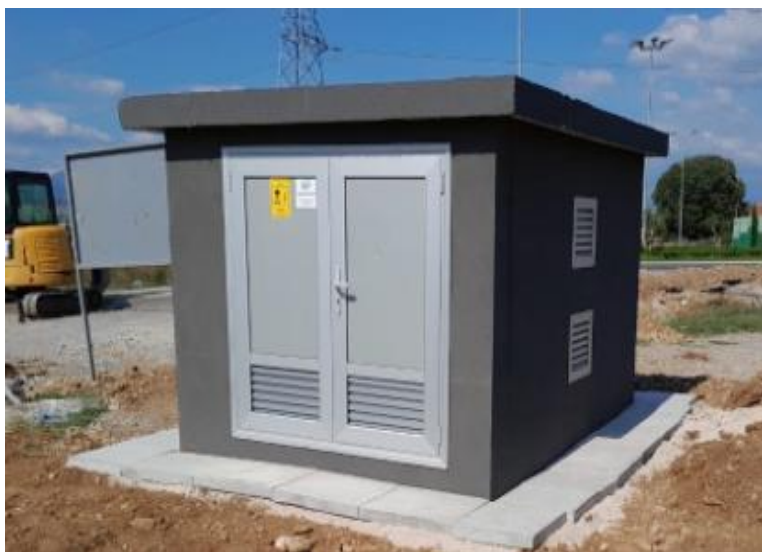
Slika 3.1.6. Primjer građevinskog objekta trafostanice
