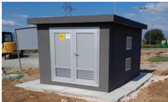
Slika 3.1.6. Primjer građevinskog objekta trafostanice
